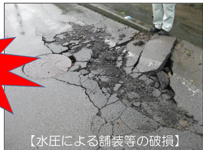
【被害発生】 平成26年8月台風11号の時に、雨水が下水管へ流れ込み、マンホールから下水が溢れ出たり、水圧により舗装等が破損する事故がありました。
