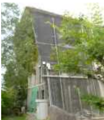
外壁に設備配管が露出（本庁舎）
