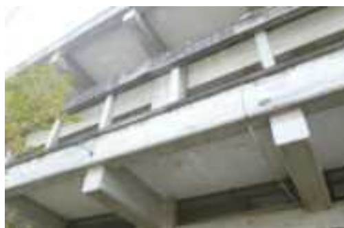
バルコニー手摺の破損（本庁舎）
