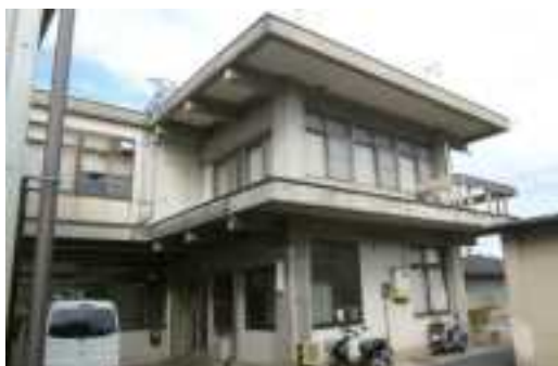
外壁に設備配管が露出（本庁舎）
