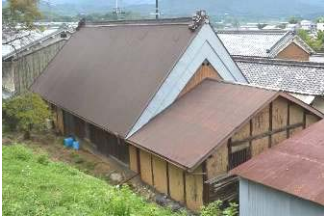
集落内に残る大和棟民家
