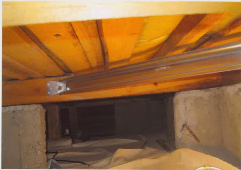
床下補強工事の写真（当時）
