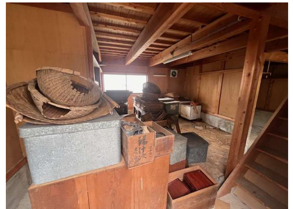
( 農業用倉庫 1階 )
